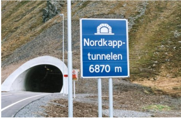
Nordkapp tunnelen, foto Statens vegvesen
